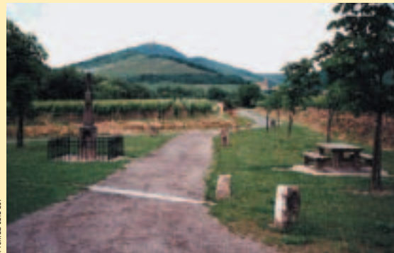
Chemin de vigne : voie verte utilisée dans le réseau cyclable du Haut-Rhin avec surlargeur pour une aire de repos et de détente
