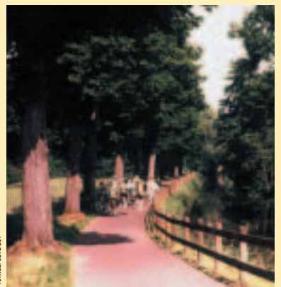
Chemin de halage transformé en voie verte (enrobé rouge) dans le Bas-Rhin avec garde-corps
