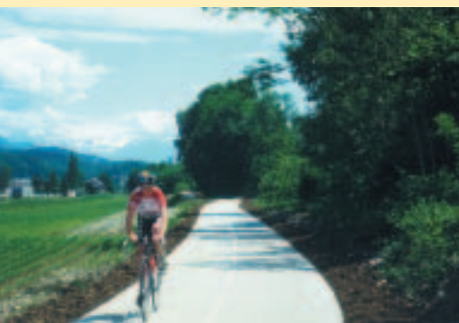
Voie verte au lac du Bourget près de Chambéry ; son revêtement en béton armé, par son absence de joints, améliore l'uni de surface par rapport au béton hydraulique
