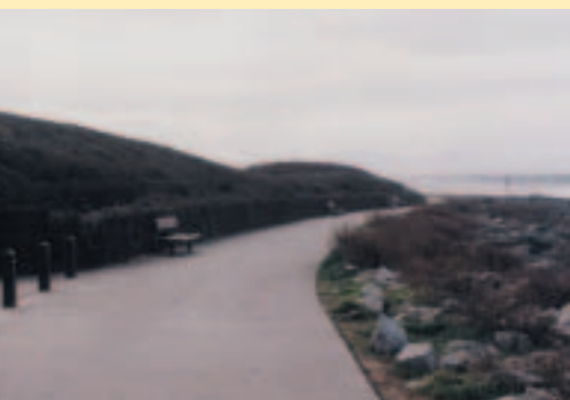
Revêtement en béton balayé dans un parc sur le front de mer à Anglet (Pyrénées atlantiques)
